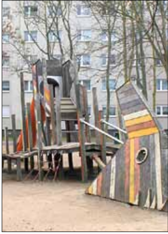
2017 werden am Spielplatz Tulpenbrunnen Reparaturarbeiten vorgenommen.
